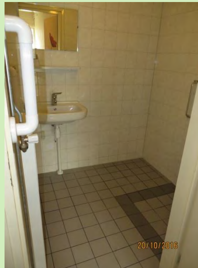
Het stucwerk in de toiletruimte wordt betegeld.
