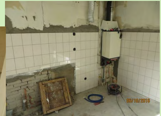
Nieuwe tegels in de keuken en badkamer.
